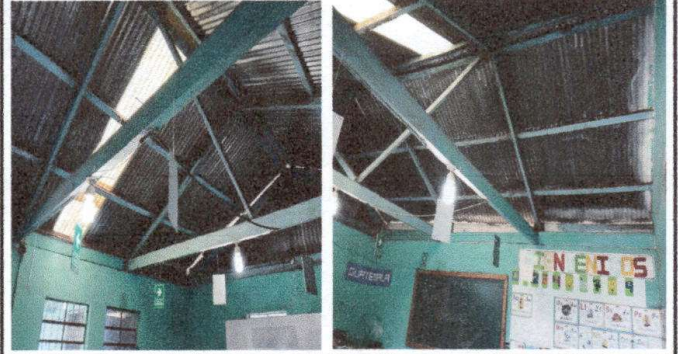
Foto 2: Cambio de lamina troquelada y sustitución de soporte de madera por meta de aulas
